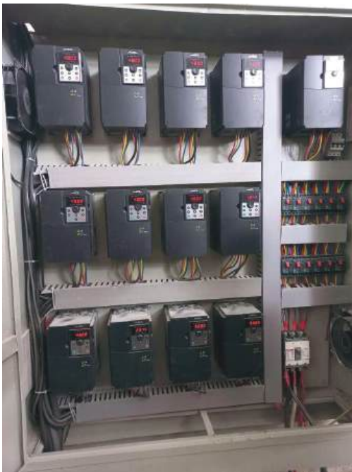
Hệ thống bơm nước nhà máy
